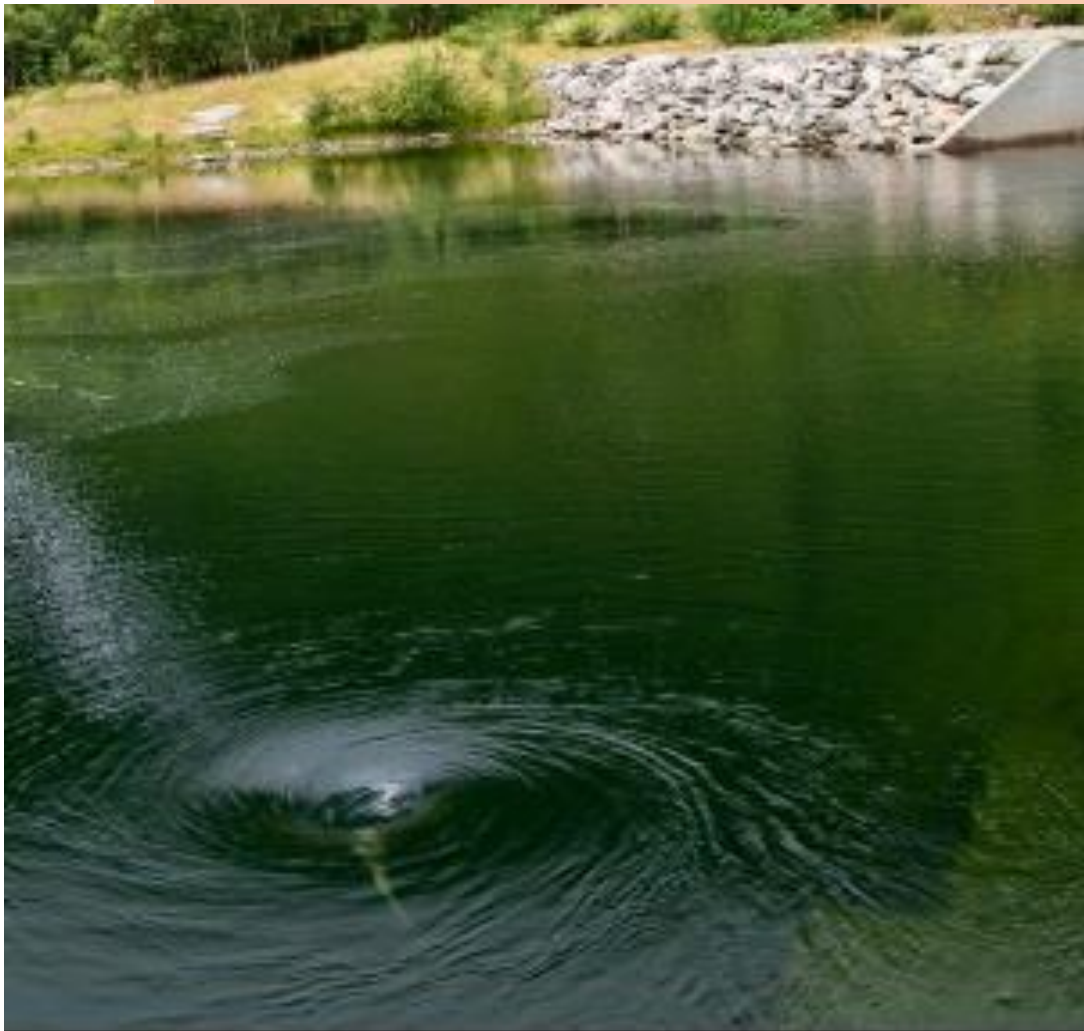
Figur 4-21: Nedadrettet virvel til inntak. (Foto: Rune Engesæter, NVE)
