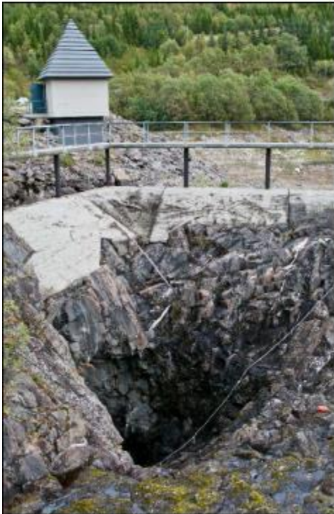
Figur 4-9: Eksempel på lukket flomløp. Her vises samme flomløp tørt og under flom. (Foto: Rune Engesæter, NVE)
