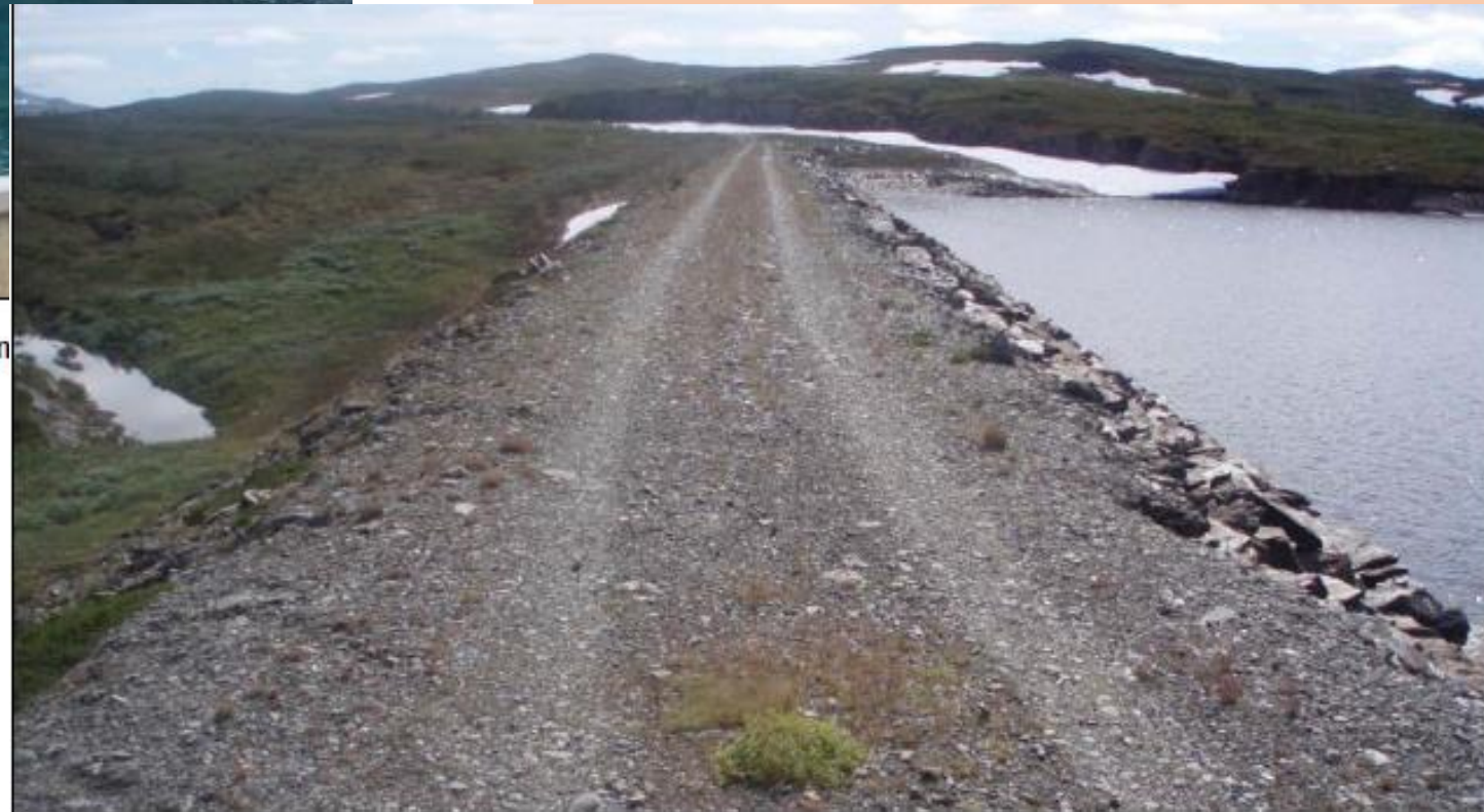
Figur 4-2: Fyllingsdam uten stabbestein, kantstein eller steinvanger. Motorisert ferdsel av uvedkommende over denne dammen er ikke ønskelig. Dammen er utbedret etter at bildet ble tatt. (Foto: Børge Hanssen, Statkraft)
