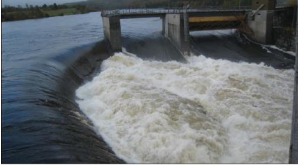
Figur 4-8: Fritt overløp og manøvrerbart flomløp under flom. (Foto: Grethe Holm Midtømme, NVE)
