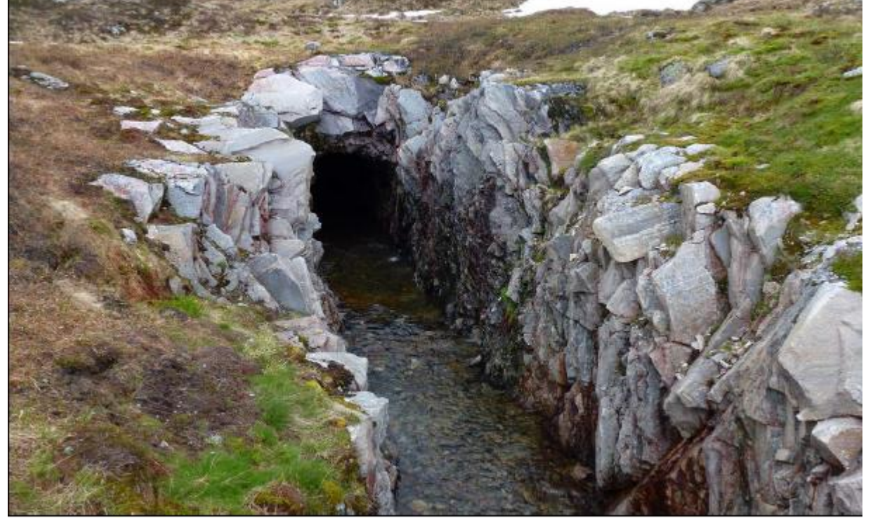
Figur 4-10: Åpen kanal uten skilting eller annen sikring. (Foto: Børge Hanssen, Statkraft)
